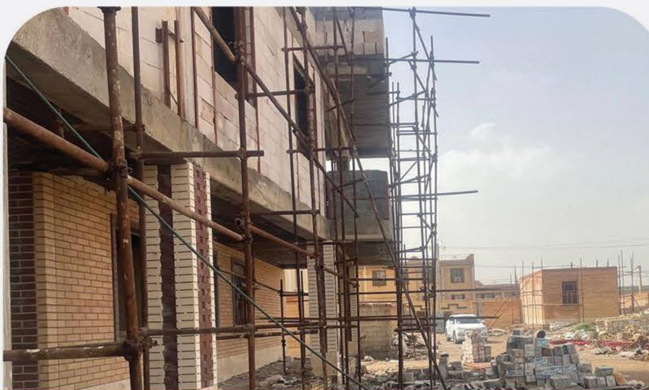
پروژه درحال ساخت مدرسه ۱۰ کلاسه شهرستان هویزه استان خوزستان
